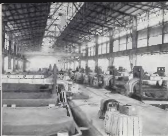
Όκτώβριος 1964. Οι πρώτες λεκάνες βρίσκονται ήδη τοποθετημένες στις αίθουσες ηλεκτρολύσεως.
