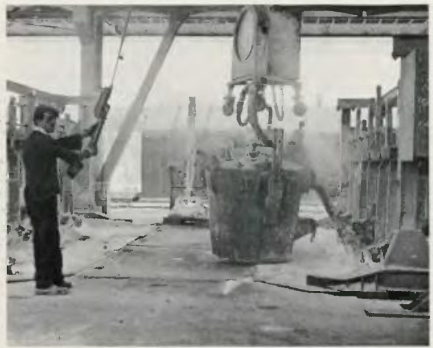
Τò μωζηθὲν μέταλλο χύνεται μέσα στους κάδους μεταφορᾶς τῶν 6 τόννων.
