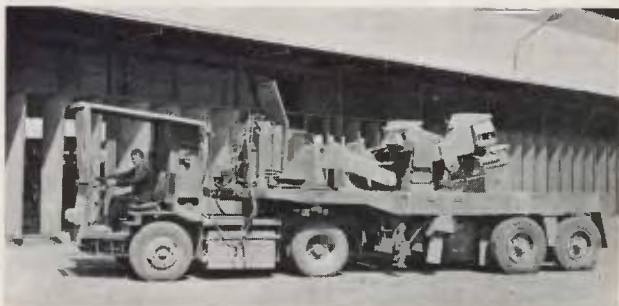
Ο κ. Σαρηβασίλης οδηγεί το ειδικό όχημα SOBEL, με το όποιο μεταφέρει στο χυτήριο τους κάδους με το ρευστό αλουμίνιο.
