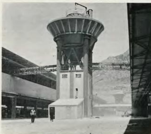
Ένα από τα τέσσερα κωνικά σιλό, που τροφοδοτούν με αλουμίνα τις αίθουσες ηλεκτρολύσεως.
